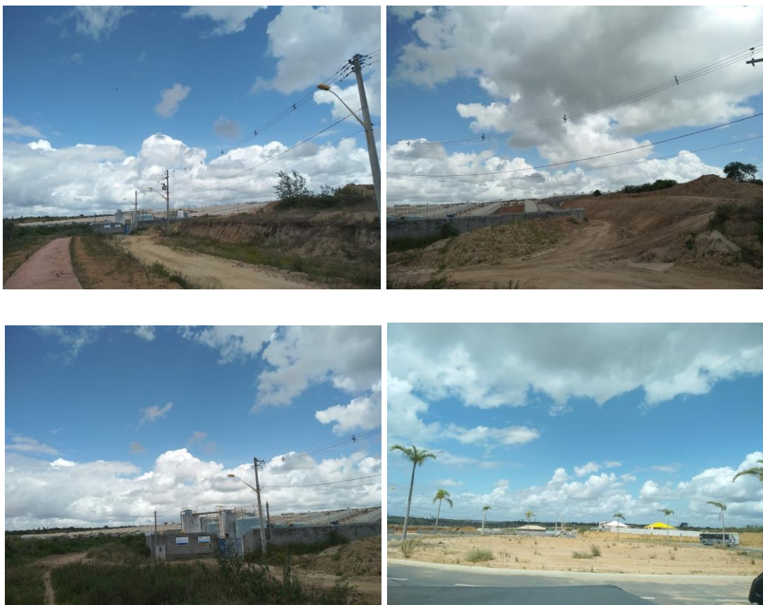
Figura 21 - Condomínio em construção no Registro
