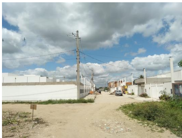
Figura 10 - Conjunto de casas com mesmo padrão construtivo
