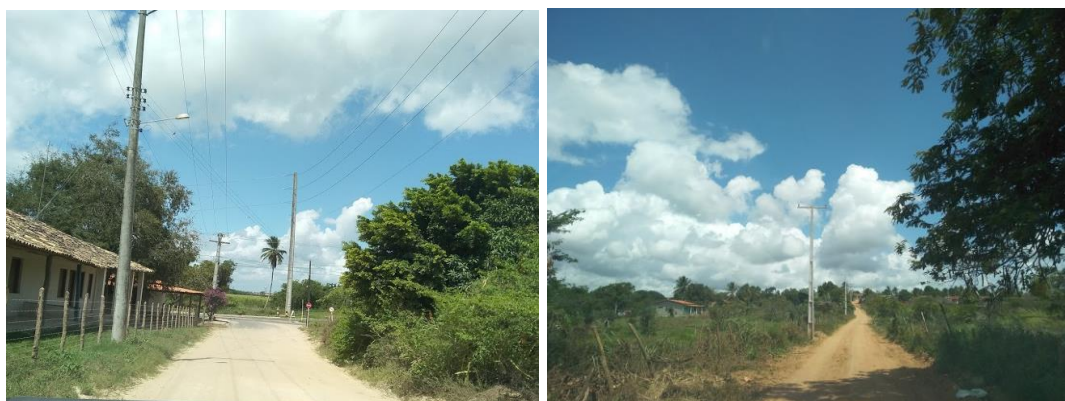
Figura 23 - Estrada do Registro
