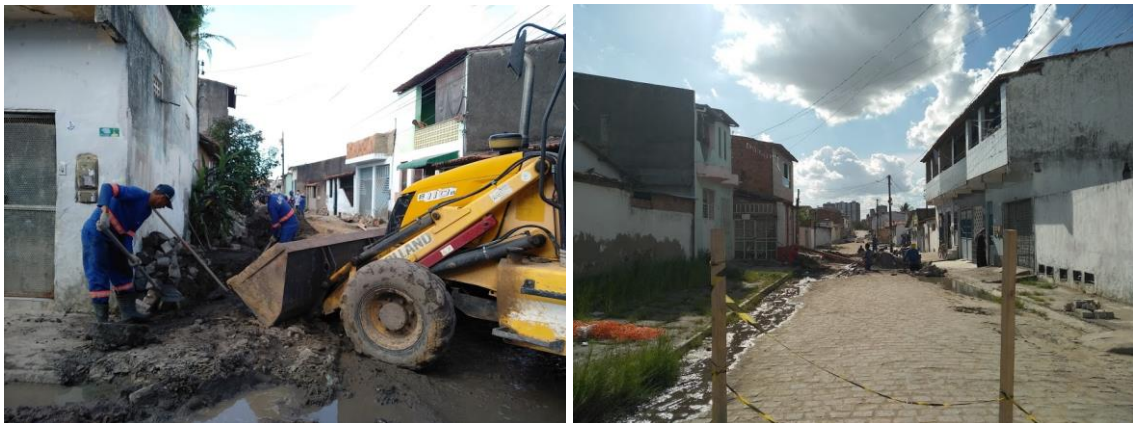
Figura 53 - Obra de esgotamento sanitário na Rua Dilton Coutinho e R. Barra do Pirai
