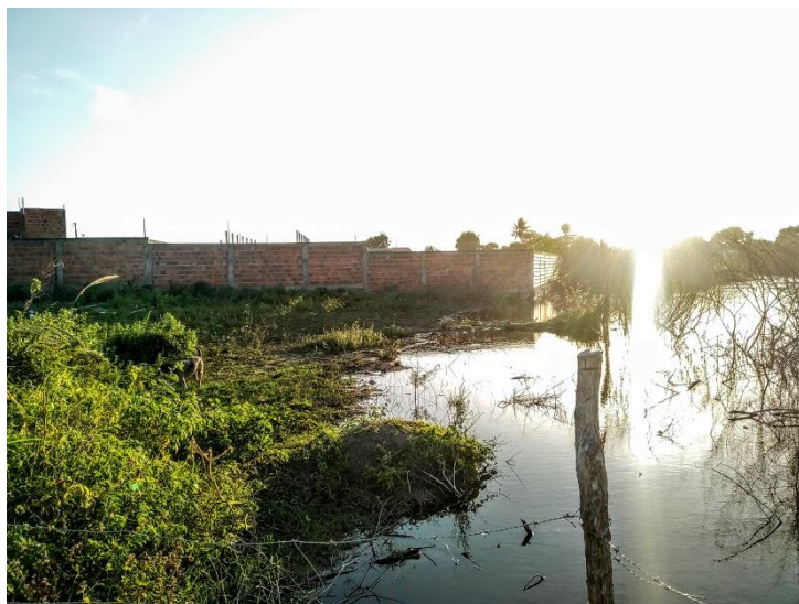
Figura 12 - Muro avançando sobre lagoa
