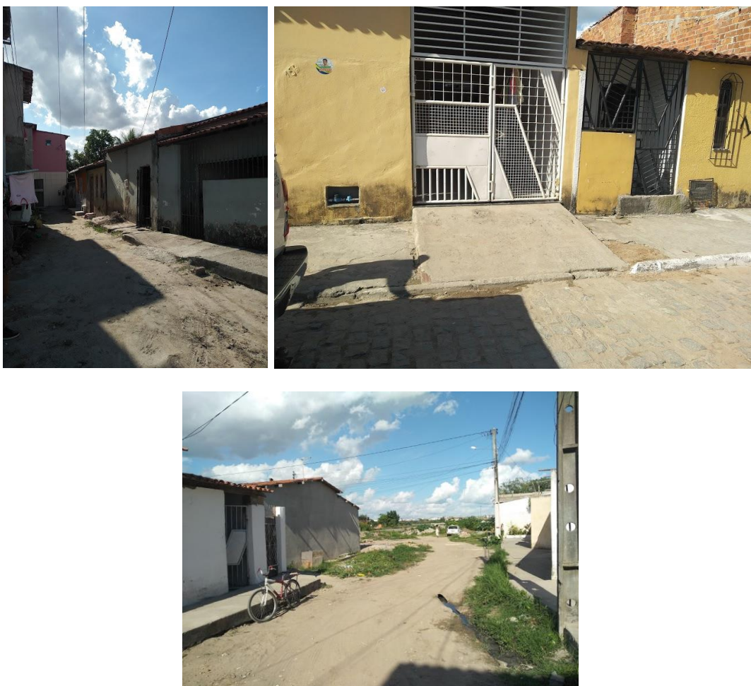
Figura 51 - Ocupações irregulares em área alagável Rua Belmiro com R. Avelino Lopes
