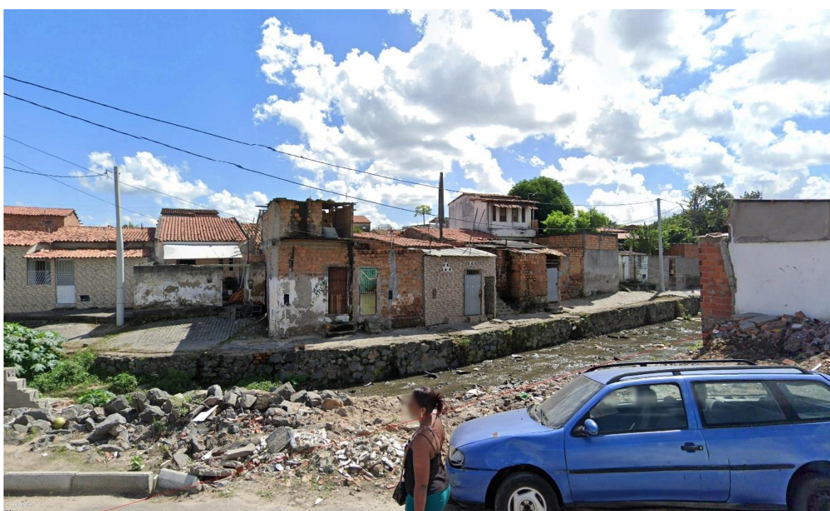
Figura 194 - Vista da seção de escoamento do canal no trecho próximo da sua interseção com a Av. Tomé de Souza
