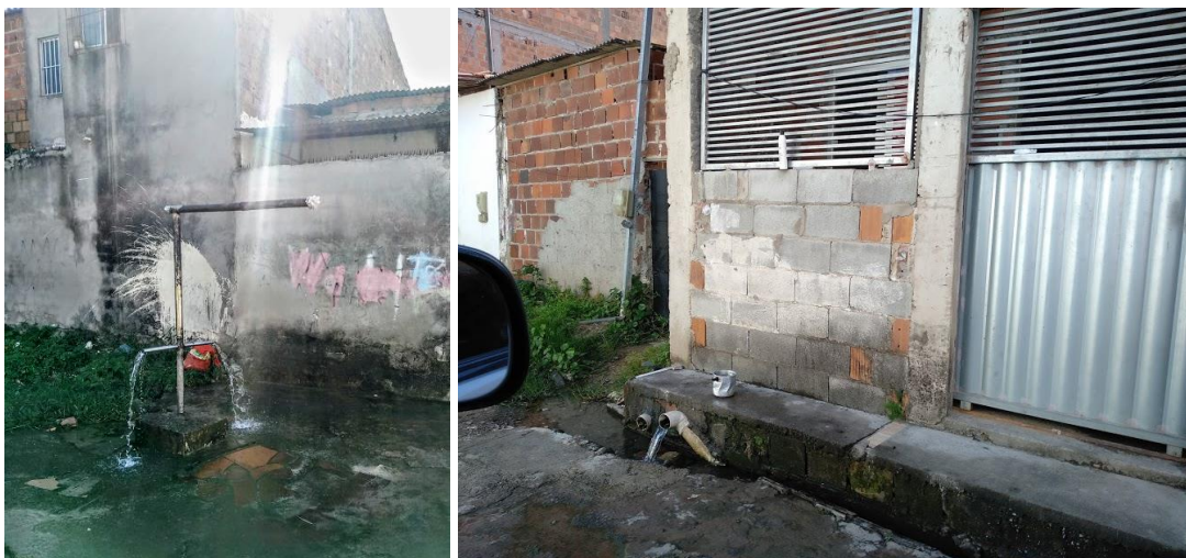
Figura 50 - Nascente na Rua Angra dos Reis e casa construída sobre nascente
