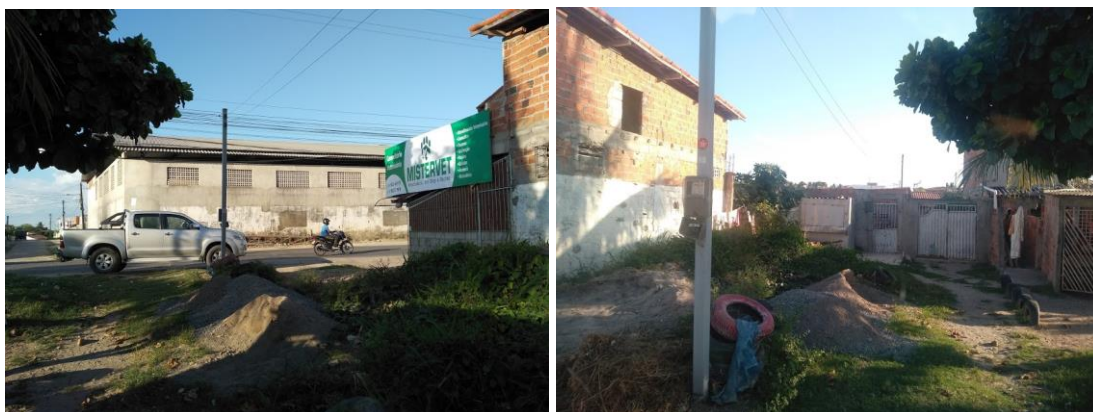
Figura 97 - Casa construída avançando sobre a Lagoa Juca Campelo na Av. Antônio Carneiro
