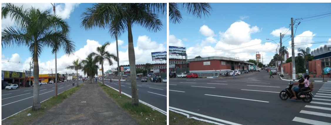
Figura 61 - Trecho alagamento Av. Presidente Dutra na rodoviária
