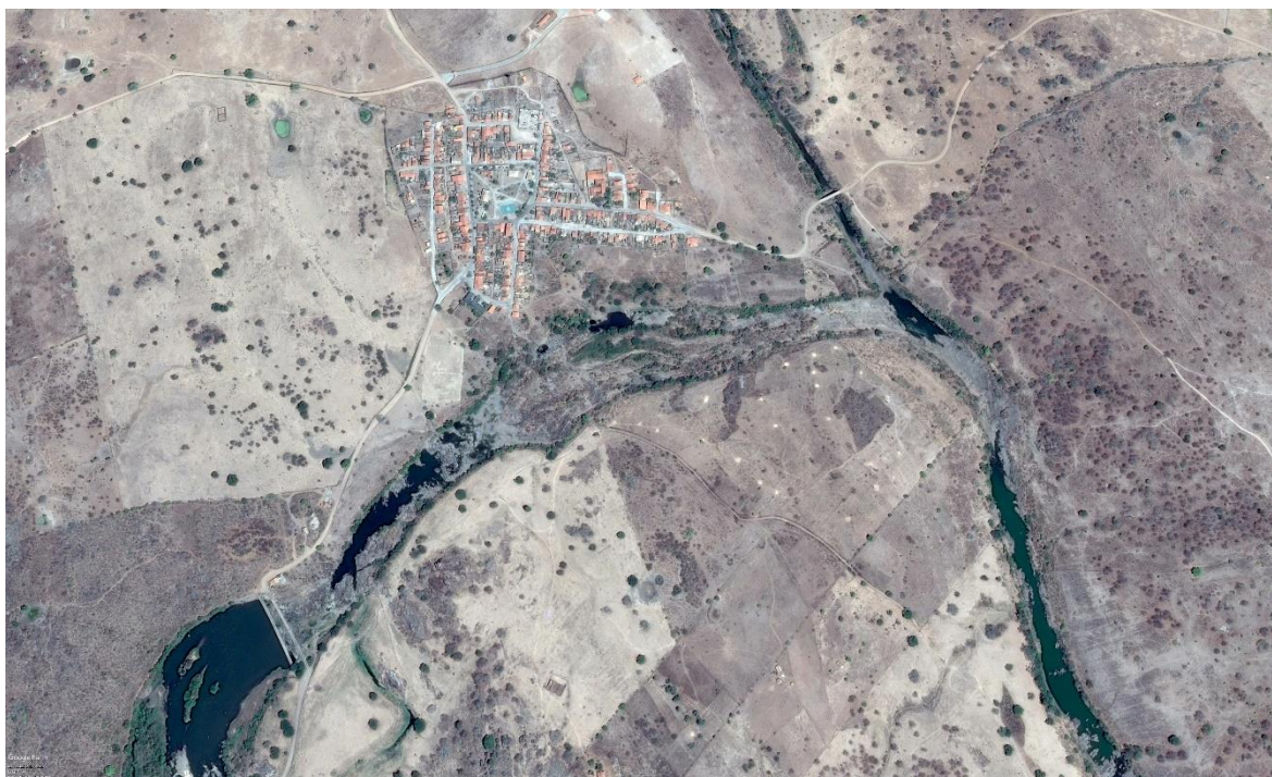
Figura 215 - Vista do trecho de jusante do canal com início do processo de ocupação das margens dele.
