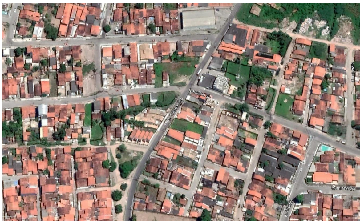
Figura 213 - Vista aérea de trecho do canal
