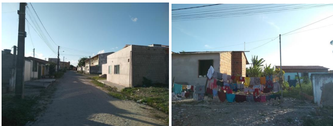
Figura 96 - Residências em situação de risco na Rua Itaíba
