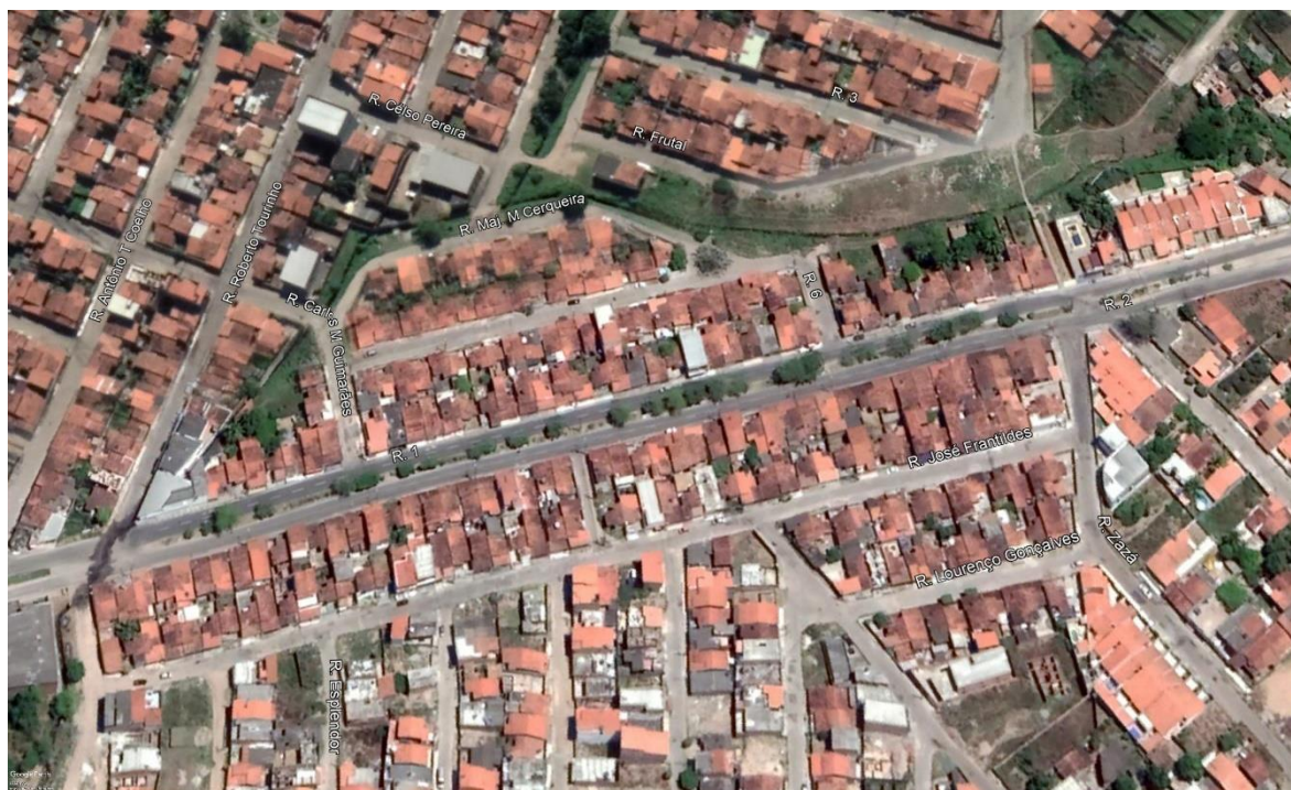
Figura 203 - Vista da ocupação do traçado do trecho inicial do canal
