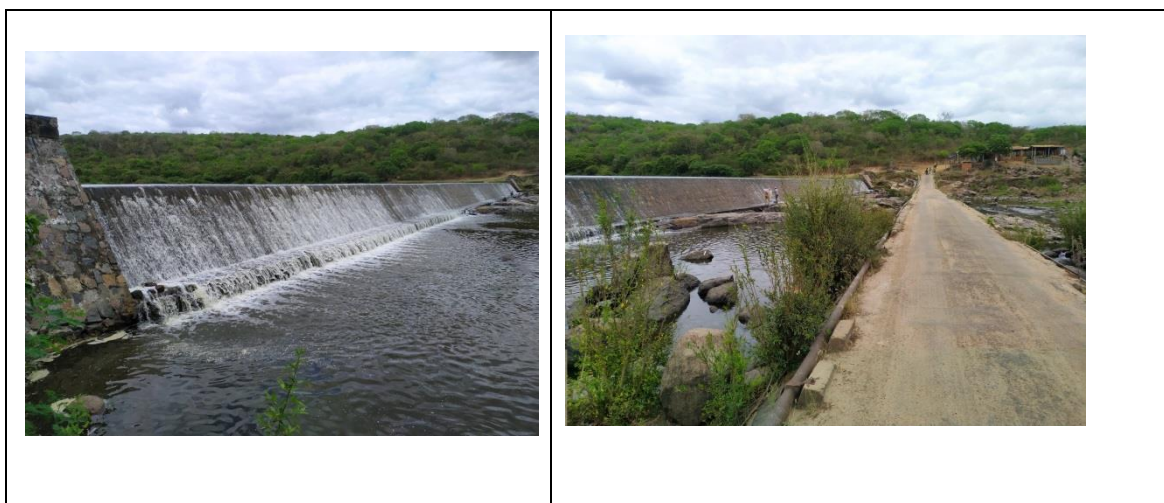
Figura 217 - Vista da barragem e da via de acesso ao distrito à jusante.
