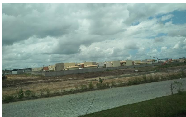
Figura 31 - Obras do Parque Linear do Bairro Papagaio
