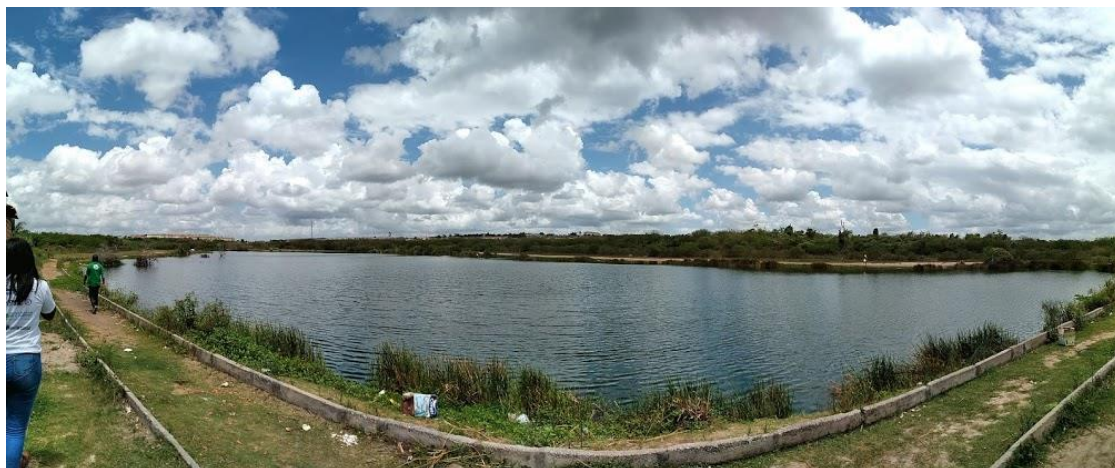
Figura 104 - Vista panorâmica da Lagoa da Pedreira
