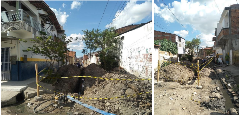
Figura 52 - Obra de esgotamento sanitário na Rua Airton Senna
