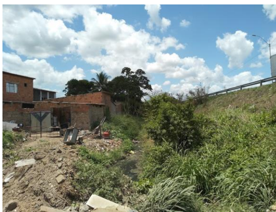
Figura 84 - Construções em área de risco na R. São Félix
