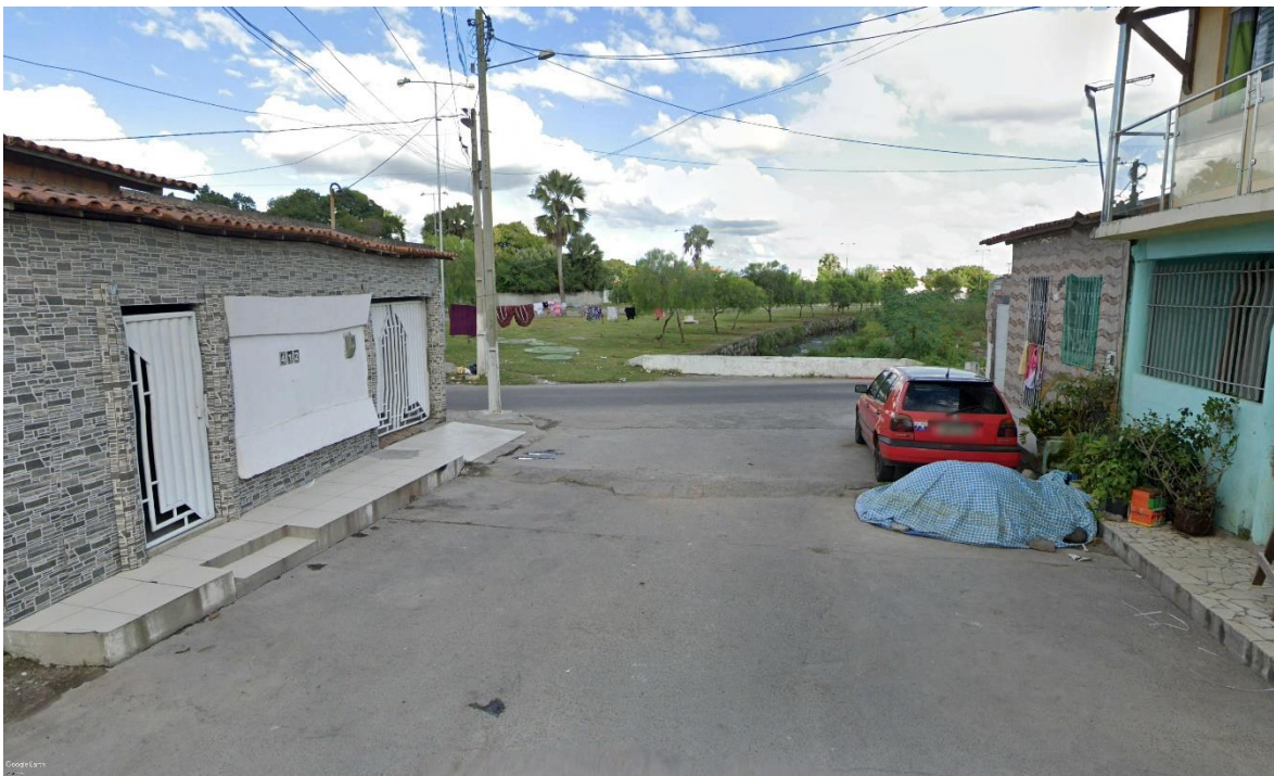
Figura 207 - Condição de proteção da edificação contra alagamentos do sistema viário observando-se no fundo da foto o canal assoreado.
