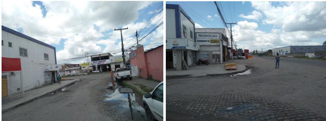
Figura 79 - Alagamento na R. Florianópolis com a Av Probahia
