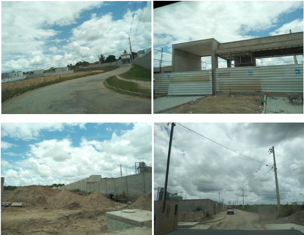
Figura 29 - Obras de condomínios no bairro Papagaio
