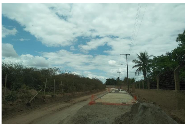
Figura 30 - Obras de pavimentação sem identificação de sistema de drenagem na Estr. do Papagaio
