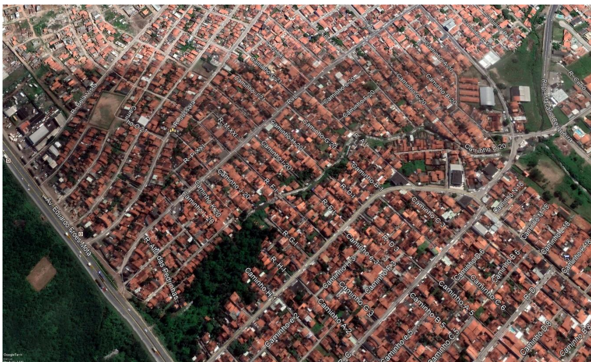
Figura 200 - Vista do traçado do trecho intermediário do canal
