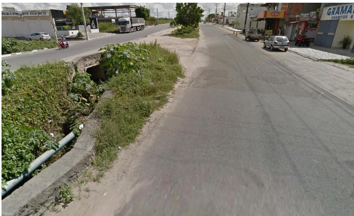
Figura 210 - Condição da travessia do canal pelas pistas da Avenida Maria Quitéria
